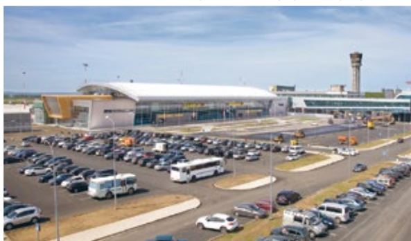
Здание терминала 1 А международного аэропорта и здание соединения с железнодорожной станцией, г. Казань
